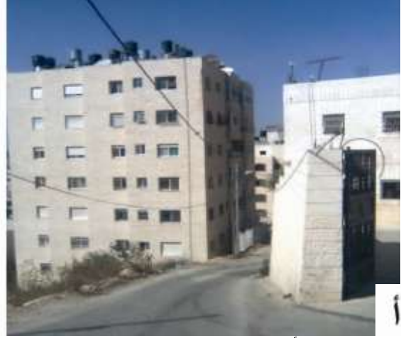
أ) البناء في حرم الشارع في مدينة بيتونيا.
