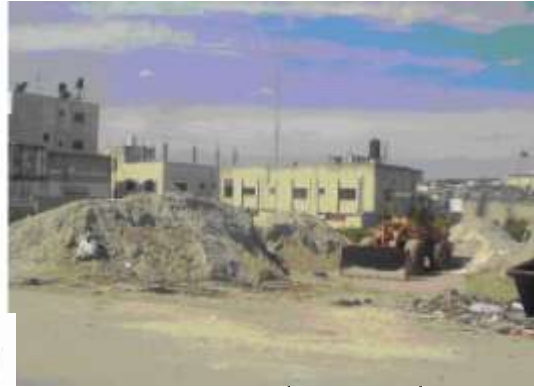
أ) استخدام الأرض الفارغة لمخلفات البناء
